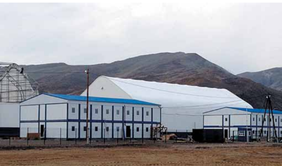
Вахтовый поселок для строителей горно-обогатительного комплекса на Элегестском месторождении
